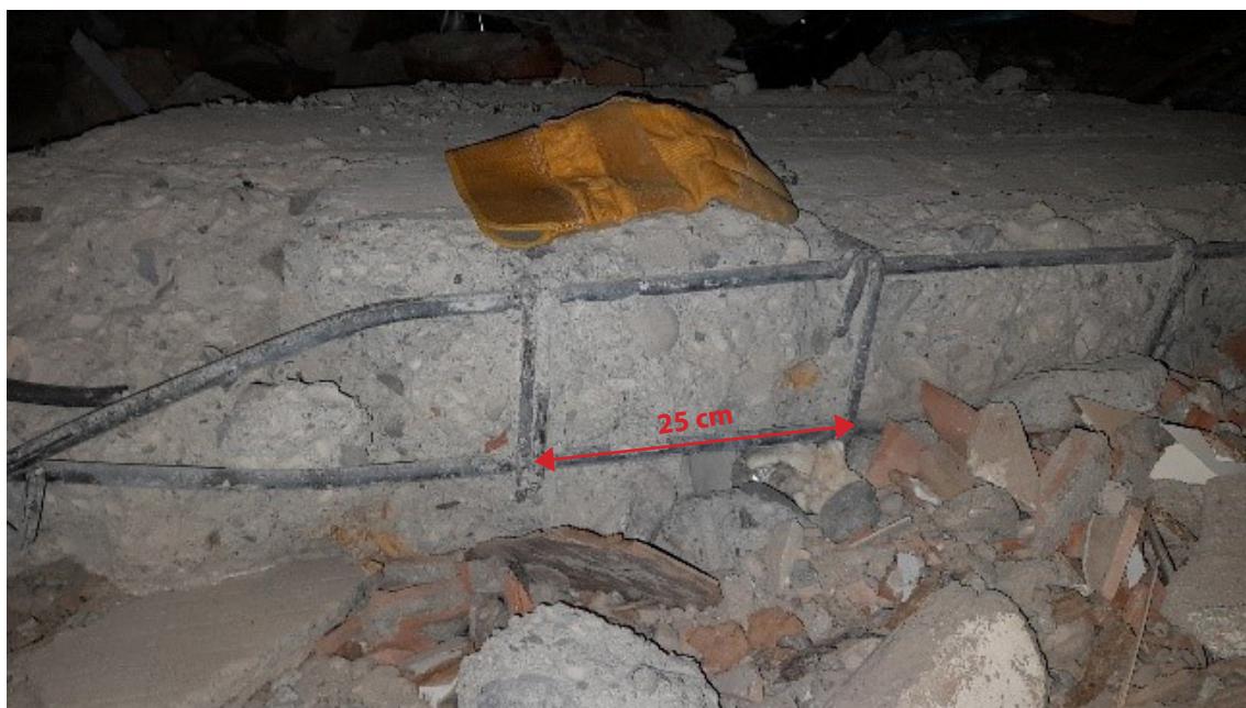
Figura N° 8. Detalle de columna del edificio Haydar Efendi
