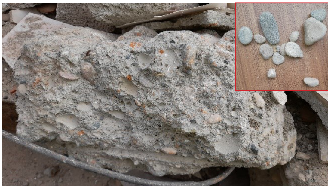
Figura N° 16. Agregado en elementos estructurales en el edificio Gap Kent Apt
