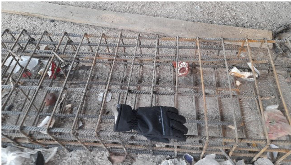
Figura N° 19. Construcción de la armadura de una viga del edificio N° 3
