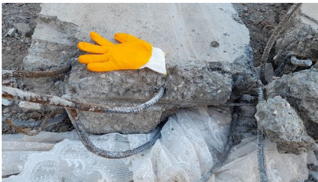
Figura N° 39. Separación del acero principal en columnas, edificio N° 8
