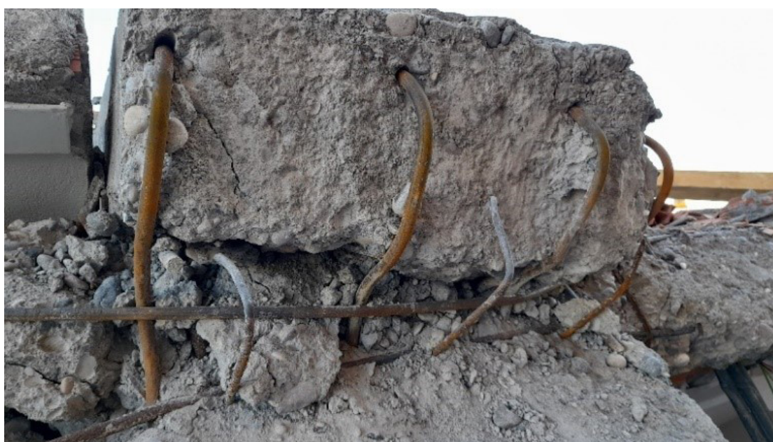
Figura N° 40. Deslizamiento interno del acero principal en columna Edificio N° 8
