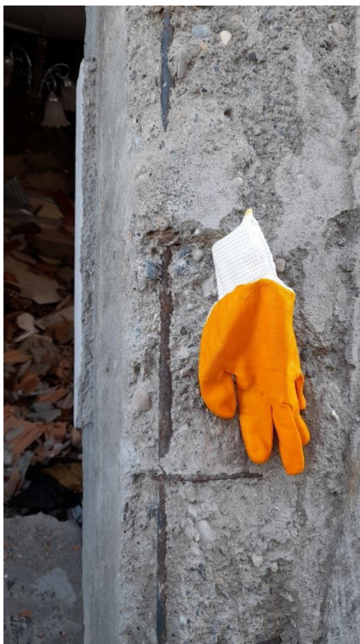
Figura N° 41. Separación de estribos edificio N° 8
