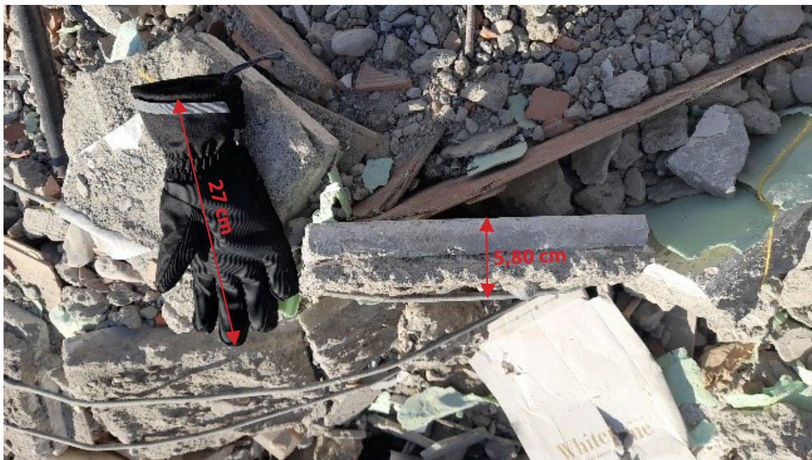
Figura N° 11. Espesor del acabado de piso del edificio Haydar Efendi
