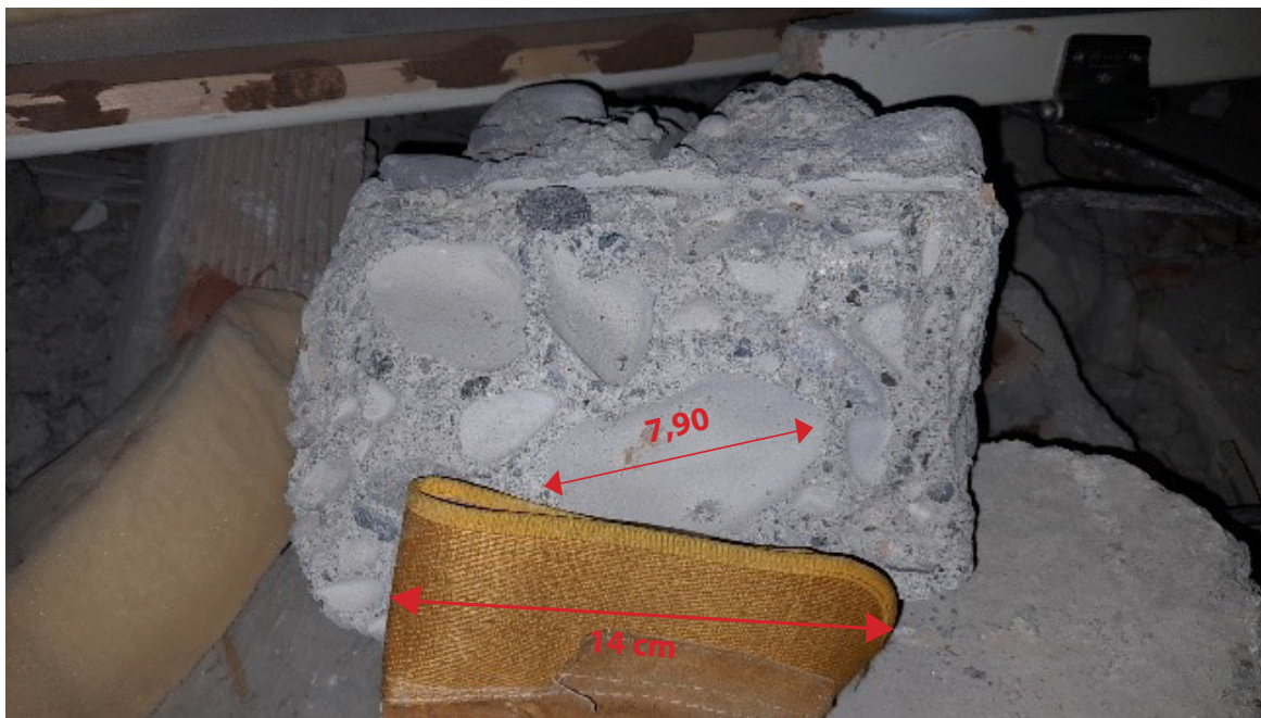
Figura N° 10. Agregado grueso en concreto del edificio Haydar Efendi
