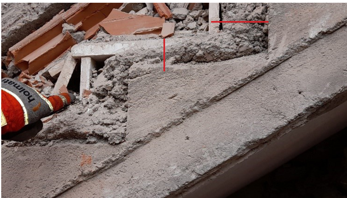
Figura N° 17. Acabado de piso en exceso, edificio Gap Kent Apt
