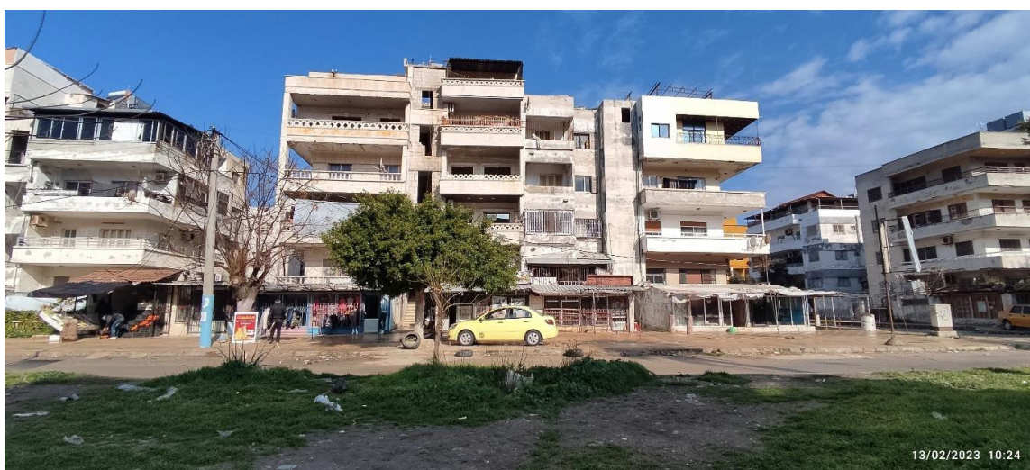
Figura N° 3. Adosamiento de edificaciones
