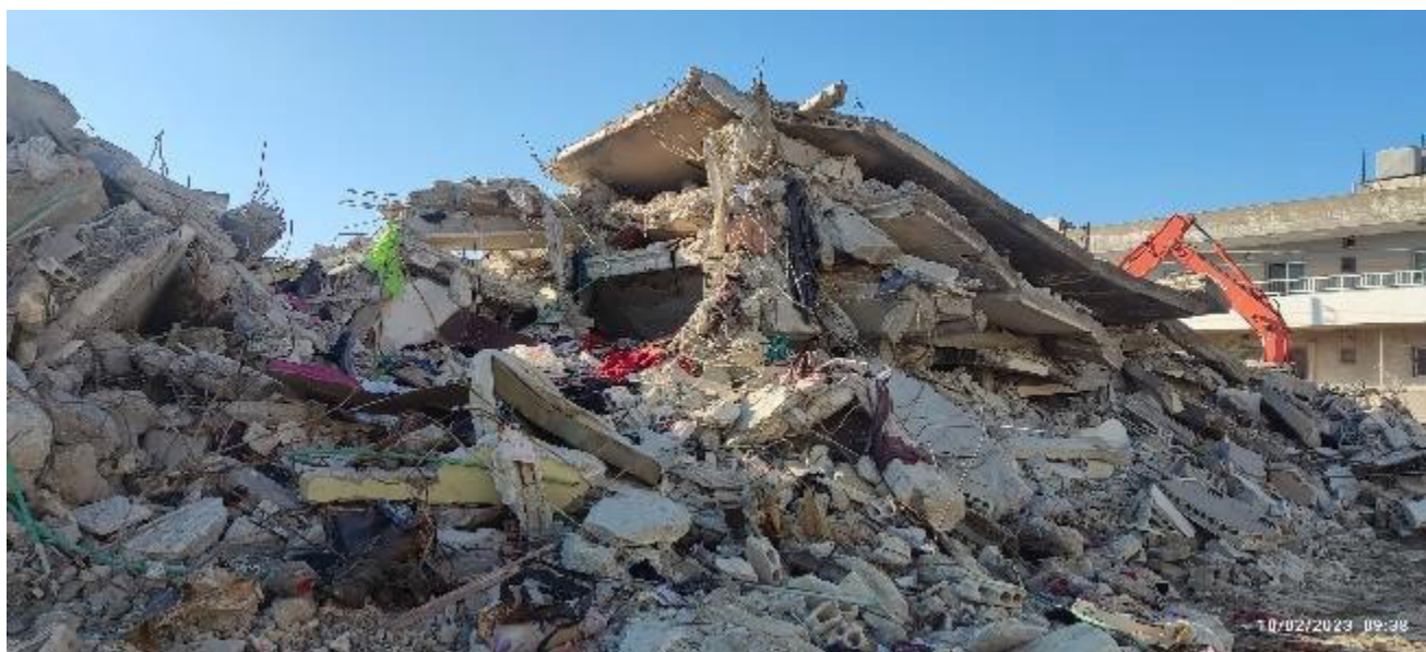
Figura N° 8. Ausencia de planos resistentes en ambas direcciones
