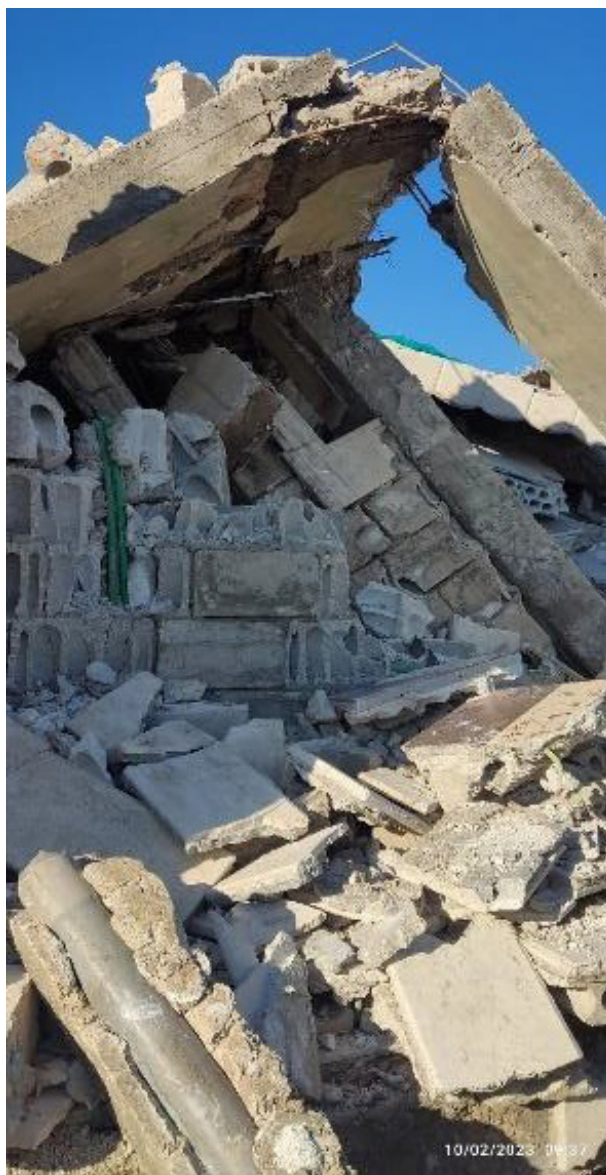
Figura N° 9. Empalme inadecuado
