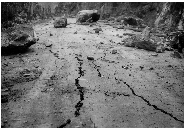
Figura N° 7. Grietas en el sector Las Adjuntas y derrumbes en la carretera El Tocuyo-Guarico
